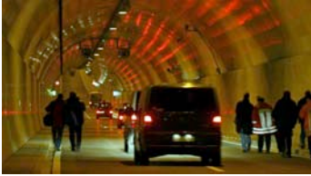
Tunnel verstärken den tieffrequenten Schalldruck
